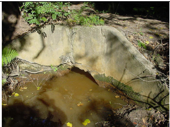
Como Parade culvert
