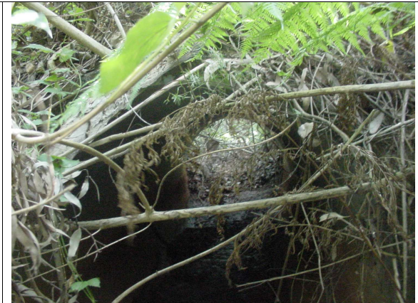
Culvert blockage at Como Parade
